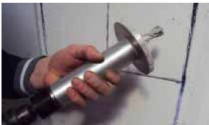
Fase 3: esecuzione perforazione con punta al widia \varnothing 18 mm
