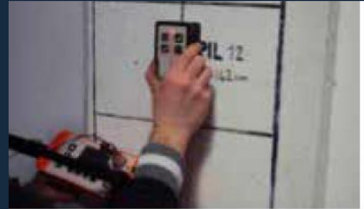
Fase 1: esecuzione indagine magnetometrica
