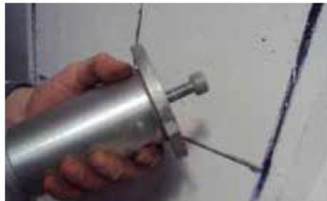
Fase 4: esecuzione alesaggio con fresa diamantata \varnothing 18 mm
