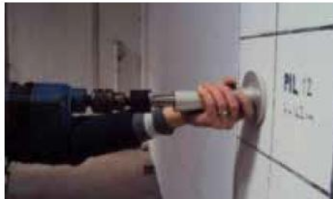
Fase 3: esecuzione perforazione con punta al widia \varnothing 18 mm
