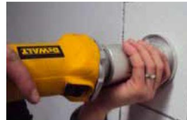
Fase 4: esecuzione alesaggio con fresa diamantata \varnothing 18 mm
