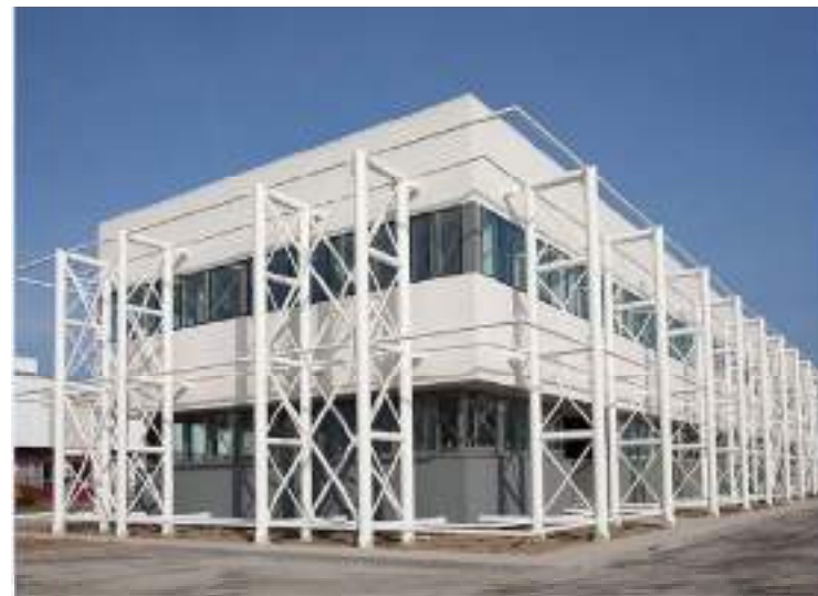
Uffici Magneti Marelli, Crevalcore (BO)
